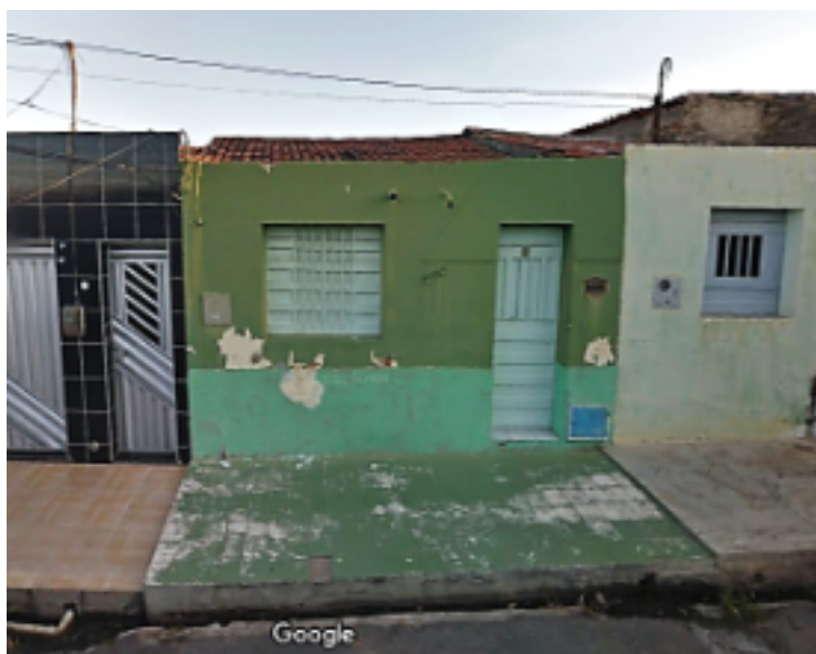
FIGURA 5 Fachada frontal da residência analisada neste trabalho (centro da imagem).
