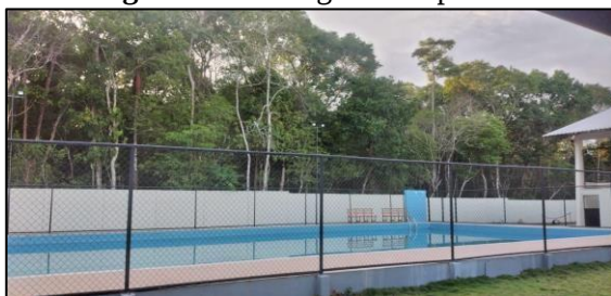
Figura 08 – Fotografia da piscina
