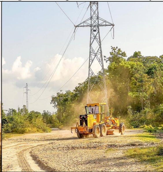
Figura 7 – Fotografia do linhão do Marajó
