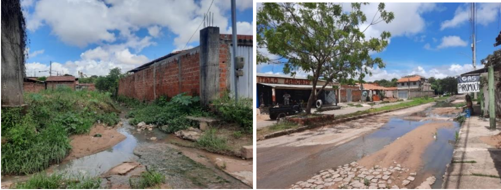
Figuras 1 e 2 - Esgoto a céu aberto, ruas alagadas e sem calçamento no Residencial Pedro Balzi
