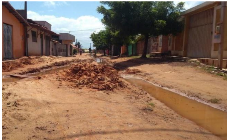
Figura 8 - Valas para o escoamento da água.
