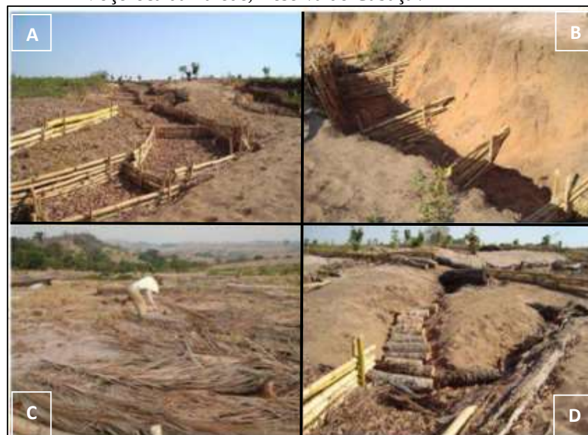
Figura 3 - A e B – Fotografias de Paliçadas laterais ( Bambusa sp. ); C – Folhas de coqueiro ( Orbignia sp. ) cobrindo o solo; D – Paliçadas de troncos de coqueiro. Bacia do Córrego Queixada, Voçoroca da Parede, Reserva do Cabaçal/MT
