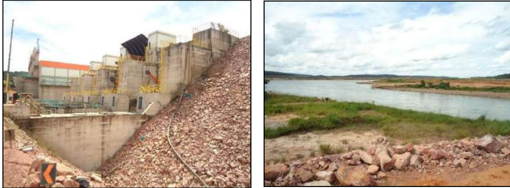
Figura 2 – Fotografia da construção da UHE Colíder e mudanças na fisiografia do canal
