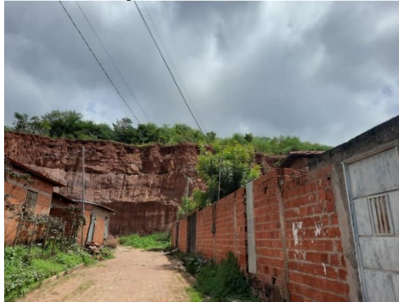
Figura 4 - Barranco existente próximo as residências no residencial Pedro Balzi
