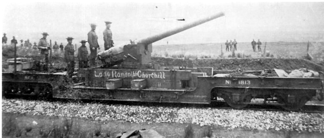
Figura 5 – O canhão naval 4,7 polegadas em reparo ferroviário, convertido por Scott por solicitação do general Barton.
