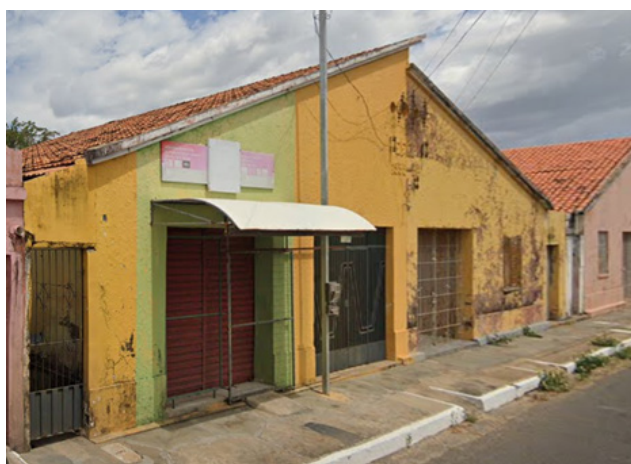
Imagem 9: Habitação conjugada com alterações de fachada situada na Vila Operária Major Santa Cruz, Parnaíba-PI.
