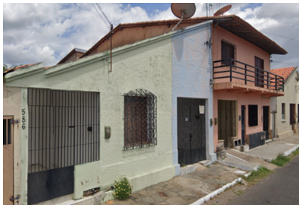
Imagem 8: Habitação conjugada com alterações de fachada situada na Vila Operária Major Santa Cruz, Parnaíba-PI.
