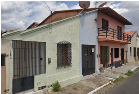
Imagem 7: Habitação conjugada com alterações de fachada situada na Vila Operária Major Santa Cruz, Parnaíba-PI.
