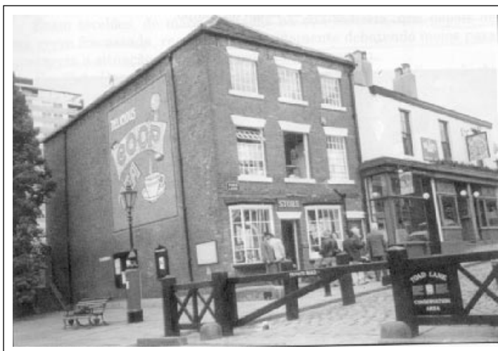
Edifício onde foi sediada a Rochdale Equitable Pioneers' Society
