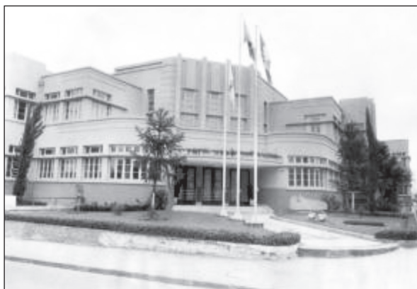
Figura 6 – Novas instalações da Escola de Aprendizizes Artífices do Paraná, em 1940, atualmente Universidade Tecnológica Federal do Paraná – UTFP.
