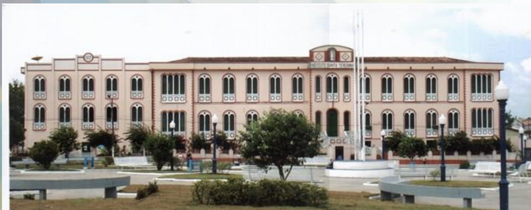
FIGURA 6 – Fotografia da Escola Confessional Santa Terezinha – Bragança/PA- Construção do início do século XX
