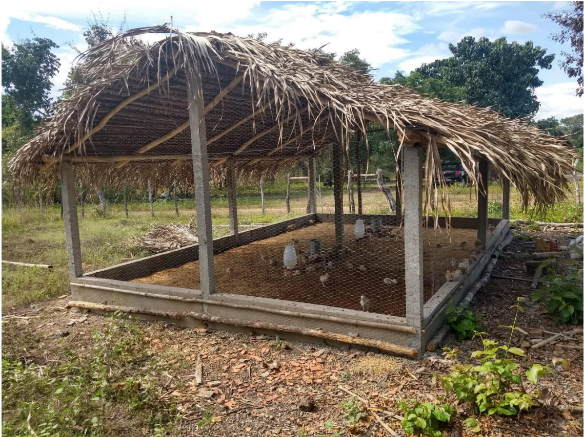
Figura 1. Aviário feito com colunas de cimento, paredes de alvenaria, madeira redonda, coberto com palha de palmeira e piso coberto com casca de arroz.
