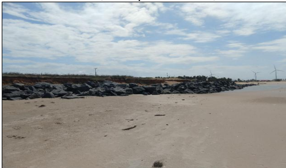
Figura 4 - Estruturas de contenção para evitar os processos de erosão, na Praia da Pedra do Sal, município de Parnaíba, estado do Piauí
