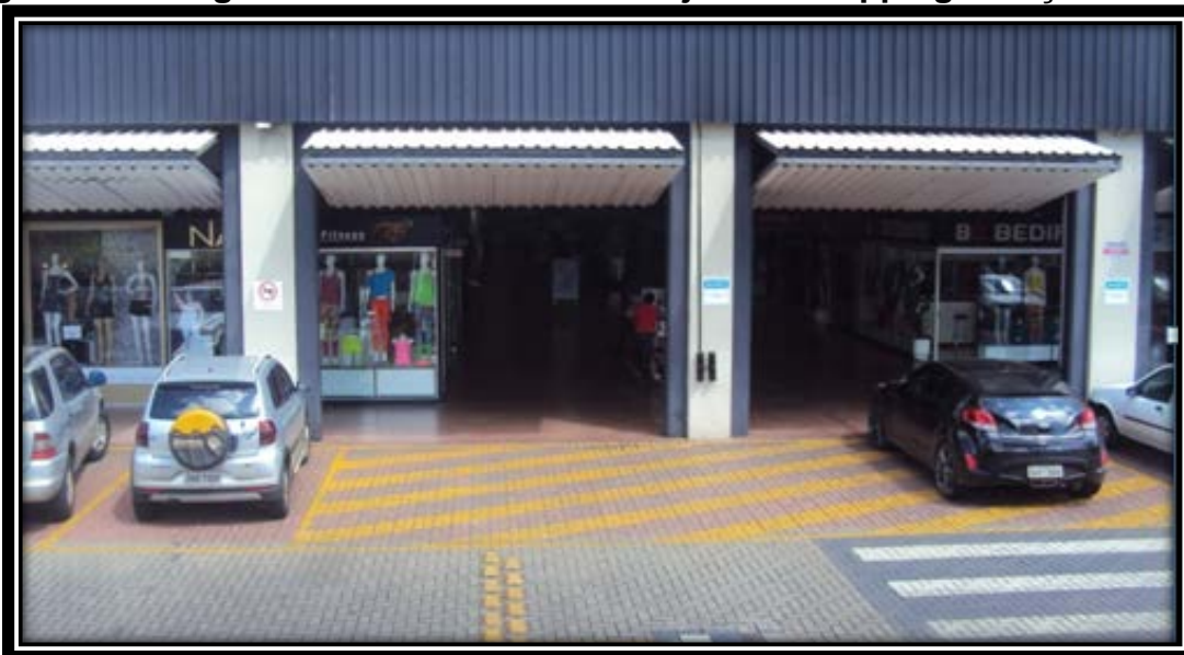
Figura 4 – Fotografia de Vista frontal das lojas do Shopping Estação Goiânia
