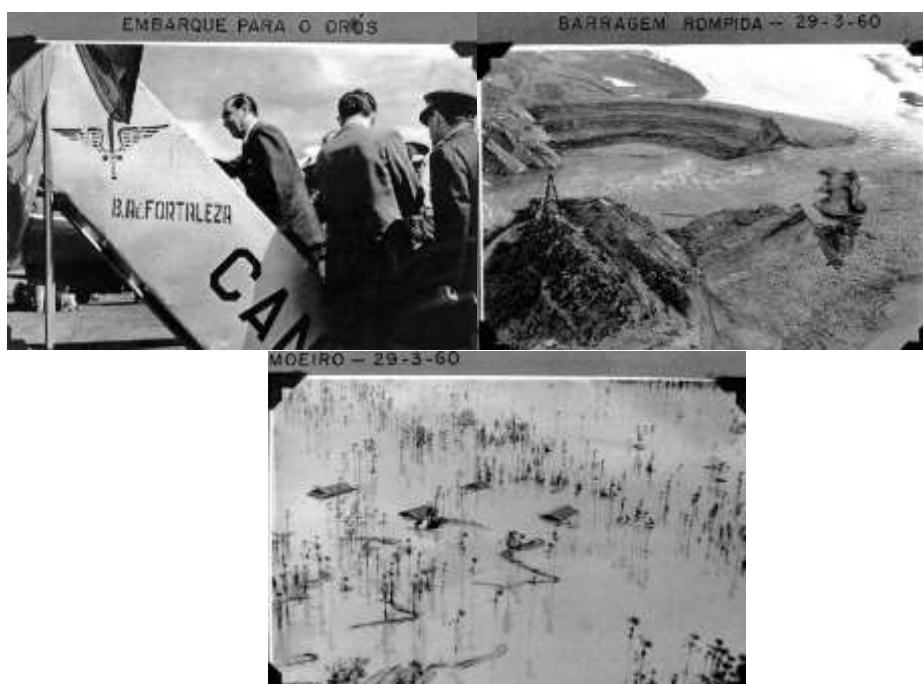
Figura 3 - Transbordamento do reservatório.
