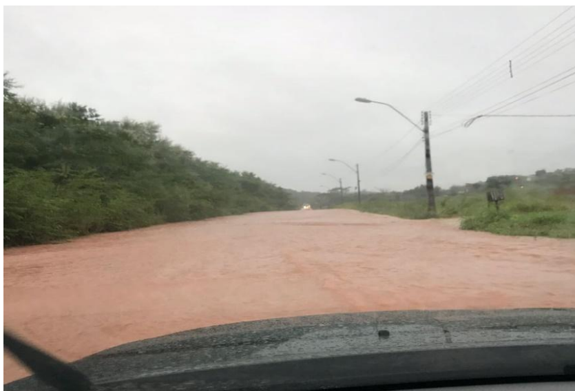
Figura 10: Trecho da rua 4 totalmente alagada (Bairro Uruguai).
