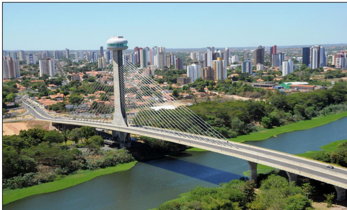
Figura 2 – Vista da Ponte Estaiada, Teresina - PI
