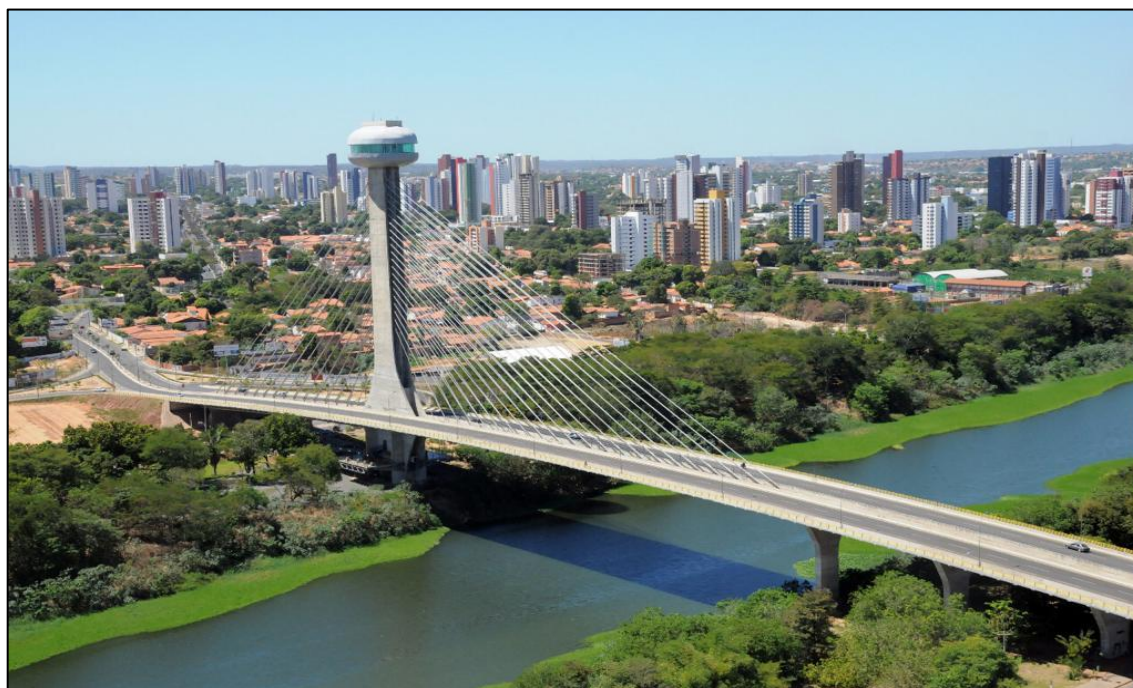
Figura 2 – Vista da Ponte Estaiada, Teresina - PI
